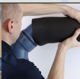
Posa facilitata dell'isolante
