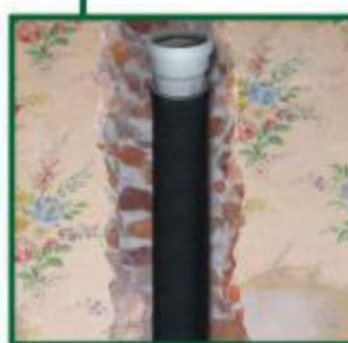
Utilizzo di FONODBAM , lastra isolante stratificata in Polietilene e gomma appesantita (4 kg/mq).
