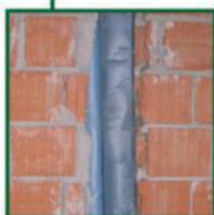
Utilizzo di FONODBAM , guaina in Polietilene monostrato di colore azzurro.
